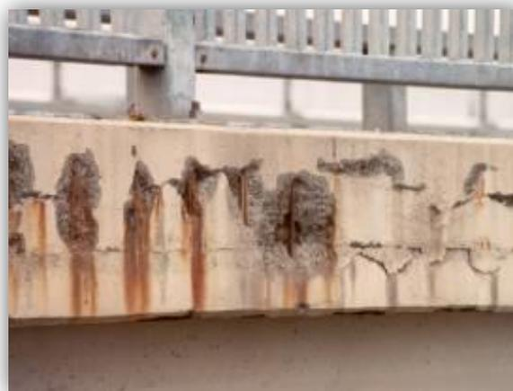
Figure 4 – *Effet des sels déglaçants sur les infrastructures*
