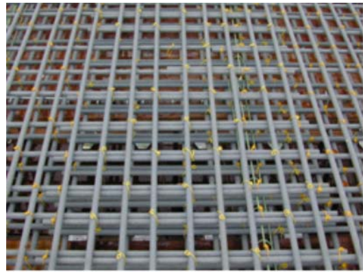
(d) Close-up for GFRP lap splice (Morristown Bridge)
