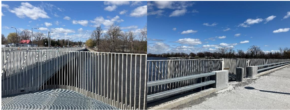
Figure 9. Vue du belvédère et accès au belvédère sur le nouveau pont
