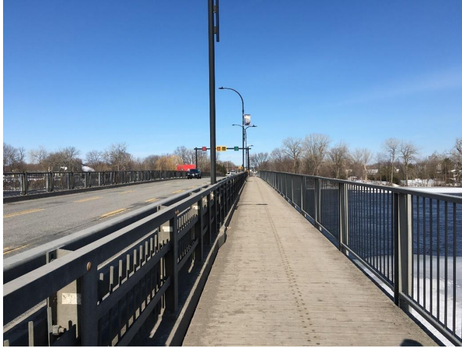
Figure 5. Vue d'un piéton sur le tablier du pont existant
