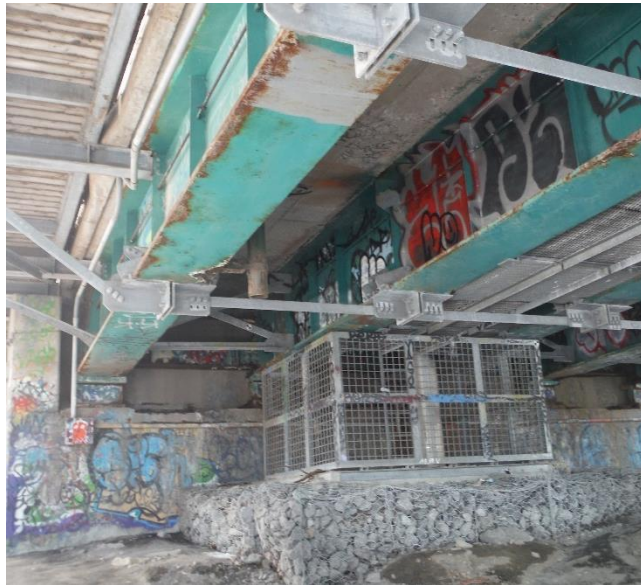
Figure 4. Aqueduc sous la structure existante
