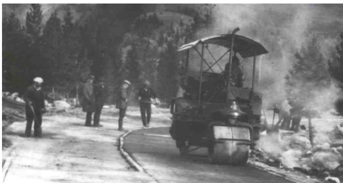
Premiers travaux de pavage commercial à l'aide de sables bitumineux à Jasper, en Alberta, en 1926 (Source : Archives publiques du Canada)
