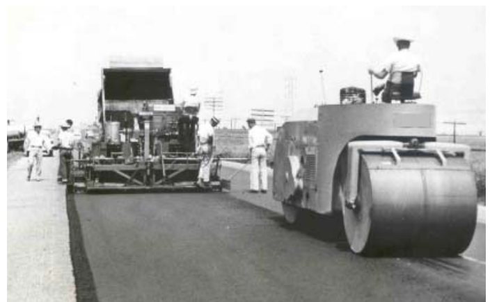
Un finisseur mécanique moderne se déplace sur la route laissant derrière lui un large ruban d'asphalte. Les rouleaux compresseurs à diesel rapides et manœuvrables ont remplacé les anciennes machines à vapeur munies de roues surélevées. Ce nouvel appareil de pavage était exposé en 1957 à la foire mondiale de l'industrie de la construction. (Source : Association canadienne des bonnes routes)
